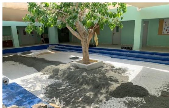
↑ 雨が降ってももう大丈夫。工事が進む UAE 中庭
